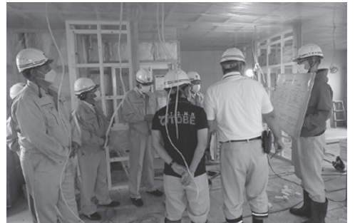
現地調査の様子(建築中の滝瀬第2団地)
