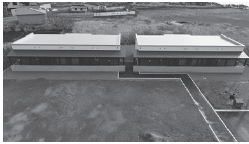
竣工した滝瀬第1団地
