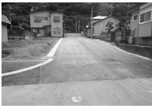
工事後の市街地1号線の様子
