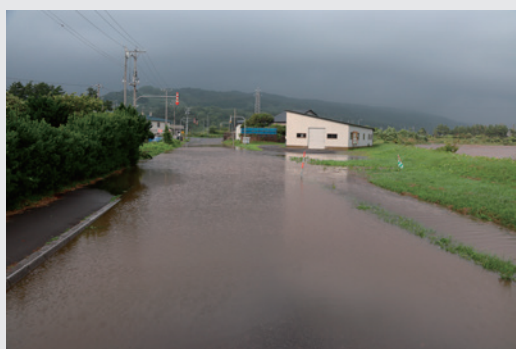
〈栄浜〉 ◁突符川から大量にあふれ出た水と、雨水の排水が間に合わずに、町道突付川沿いの道路が冠水しました。（19日午後2時ころ）
