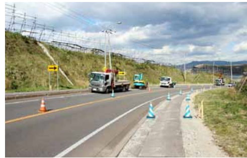
▶ガードパイプ設置工事の様子
